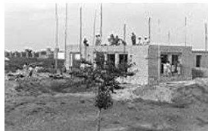
067 FMM 000510 13061939 CEMENTERIO NUEVO EN CONSTRUCCIÓN. 13.06.1939
