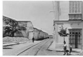
072 FMM 000521 24071939 DERRIBO DE FINCA EN CALLE MURO. 24.07.1939
