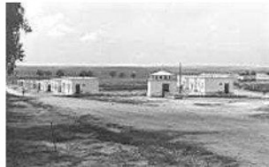
065 FMM 000507 11061939 BARRIADA DEL PILAR EN COSNTRUCCIÓN. 11.06.1939
