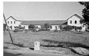
020 FMM 000317 00091934 COLONIA CAULINA (EDIFICIOS CENTRALES) 00.09.1934
