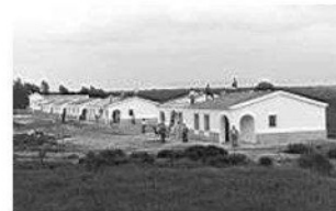
068 FMM 000511 13061939 CONSTRUCCIÓN DE CASAS EN LA FLORIDA. 13.06.1939
